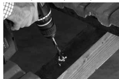
Шаг 2. Сверление отверстия в стропиле
