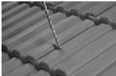
Шаг 1. Сверление отверстия в кровле
